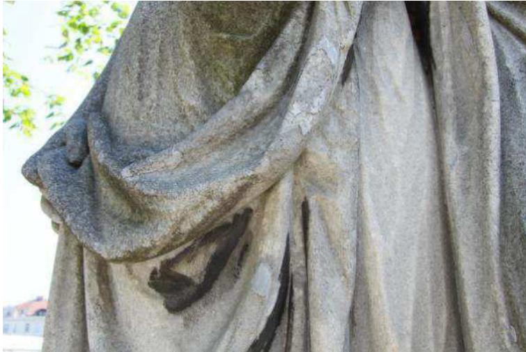
Mörtelergänzungen in Form von Kittungen an den Gewändern von "Hesperia und Arethusa" (Nr. 39).
