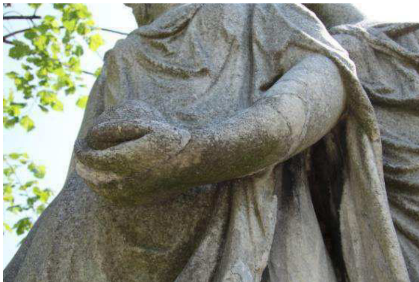
Arm der "Hesperia" (Nr. 39) mit sekundär geschlossenen Rissen.
