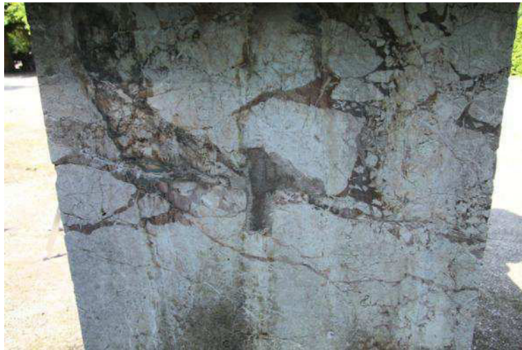
Sockel des "Cinsinnatus" (Nr. 36) mit "Mattscheibeneffekt", verklammertem Riss und div. Kittungen.
