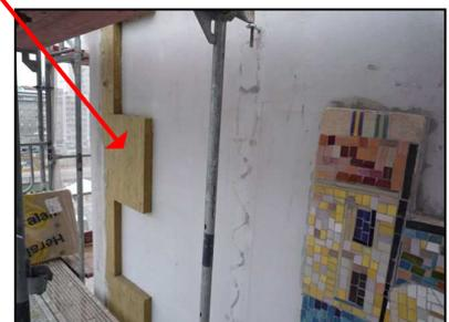
*Im Mauerwerk verklebte Stahlanker: zusätzlich zur Verklebung der Platten an der Oberfläche mittels Klebemörtel wurde jede Platte mit ca. 2 Stahlankern im Mauerwerk verankert.*
