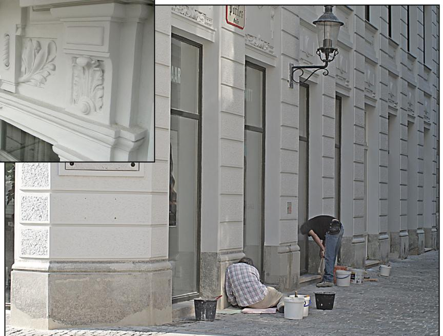
^ Instandsetzung der Sockelzone aus Kalksandstein Ansicht während der Arbeiten
